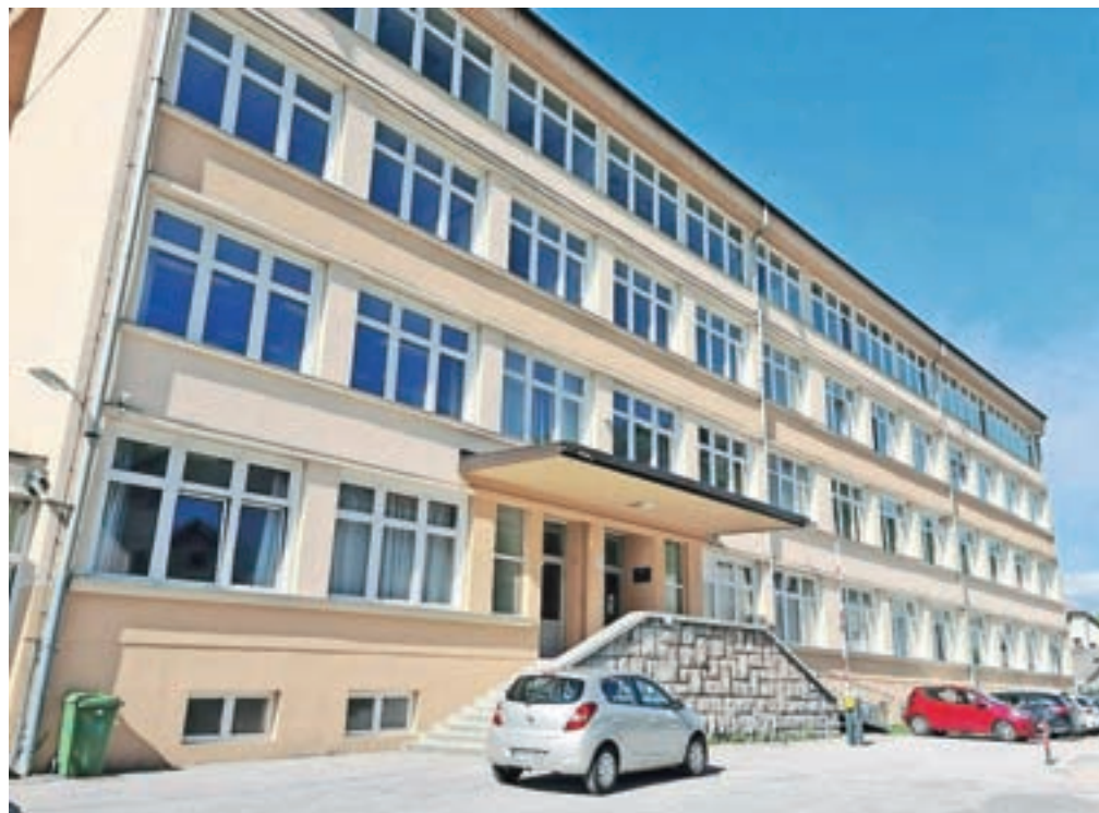
Stavba Srednje šole Jesenice: celovita obnova se začne.
