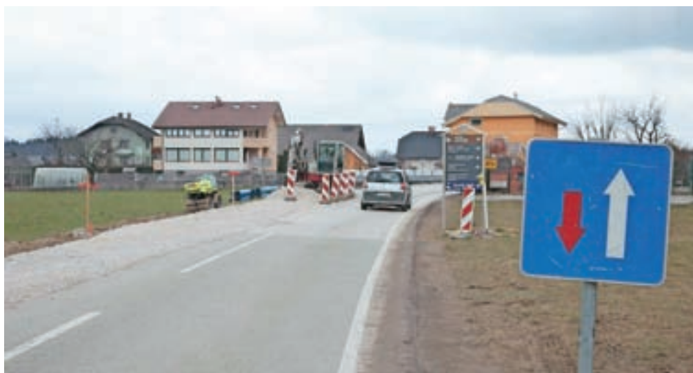
Zgrajena je že približno polovica vodovoda. / Foto: Gorazd Kavčič
