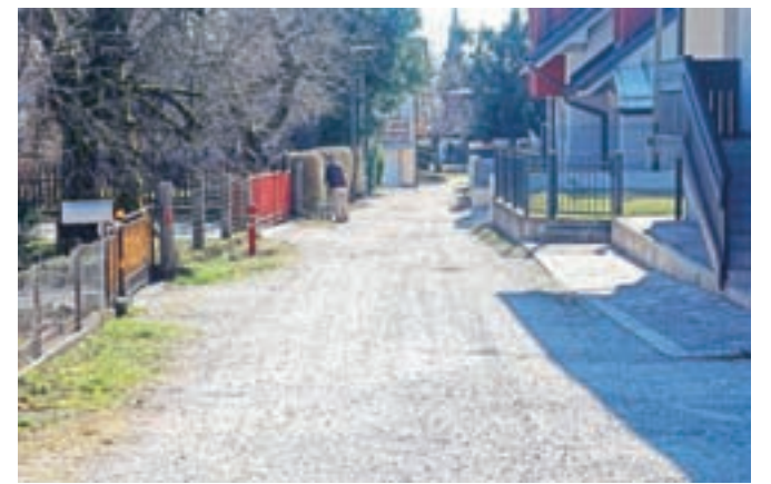
Del Kajuhove ulice v Kranju, ki je še vedno makadamski, naj bi asfaltirali do poletja. /Foto: Gorazd Kavčič
