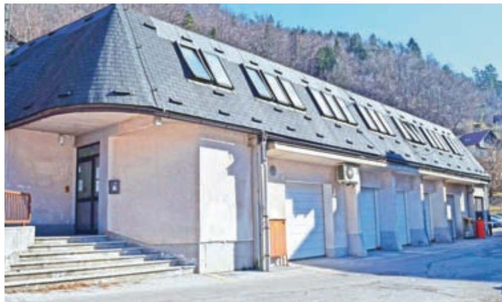
Stavbo na Titovi 78a ob jeseniškem zdravstvenem domu bodo obnovili in v celoti namenili zdravstveni dejavnosti. V spodnji etaži so že zdaj garaže za vozila nujne medicinske pomoči.
