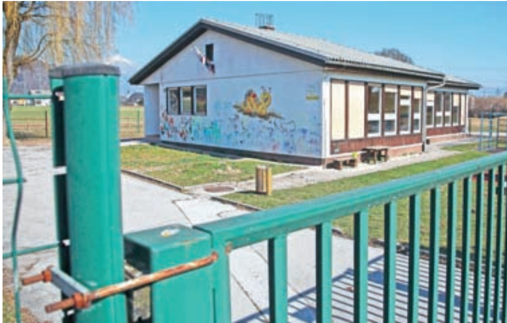
Zdajšnji Vrtca Biba v Zgornjih Bitnjah, zgrajen leta 1973, bodo v ponedeljek začeli rušiti.
