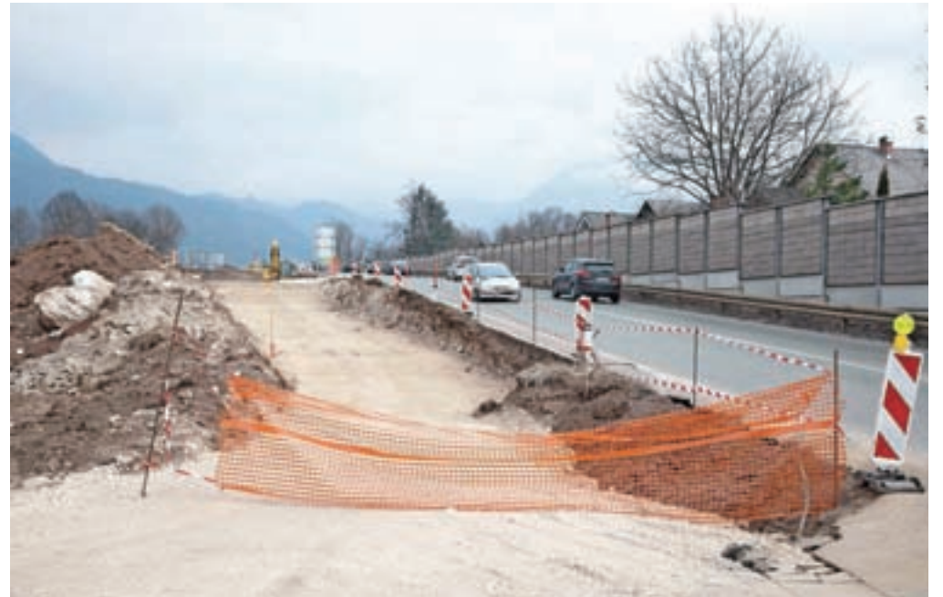
Cesta od krožišča pri Lescah proti semaforiziranemu križišču za Bled je ponovno gradbišče, urejajo štiripasovnico. Pred dobrim letom dni zgrajeno protihrupno ograjo pa bodo podrli, jo povišali in ponovno postavili. / Foto: Gorazd Kavčič
