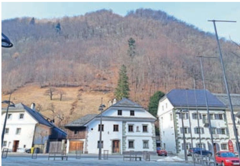
Za zaščito pred skalnimi podori bodo na strmi brežini nad naseljem Na plavžu namestili 426 metrov podajno-lovilnih sistemov.
