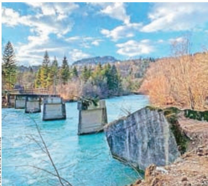
Stari most že rušijo, do konca leta bo zgrajen nov.
