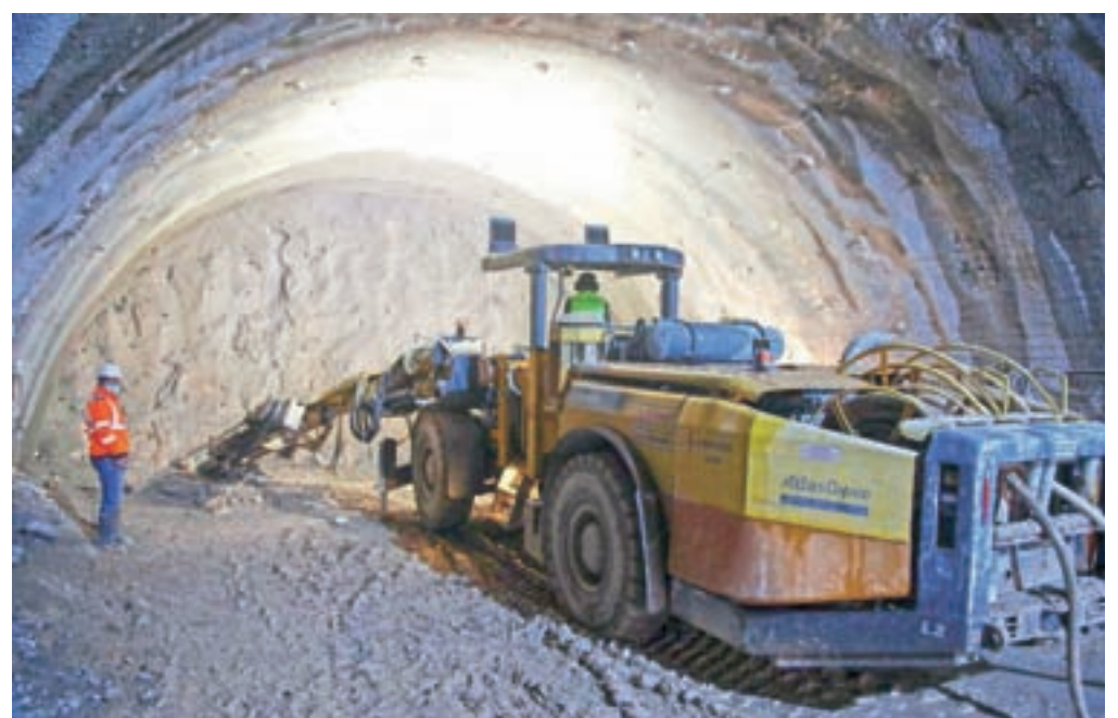
V samo enem dnevu so delavci Cengiz Insaata izkopali enajst metrov predora. / Foto: Gorazd Kavčič
