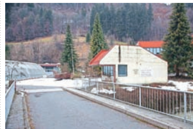
V kompleksu nekdanje Lepenke so proizvodno-skladišni objekti, upravna stavba z vratarnico in pripadajoči pomožni objekti. / Foto: Gorazd Kavčič
