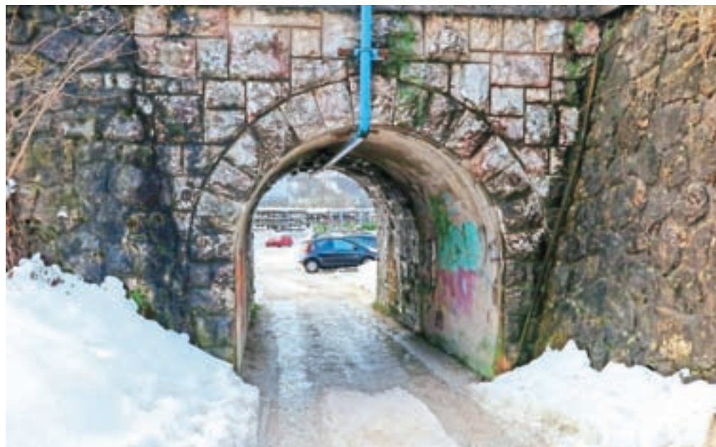
Kamnit obok iz časov avstro-ogrske monarhije bodo ob gradnji novega nadvoza morali porušiti.
