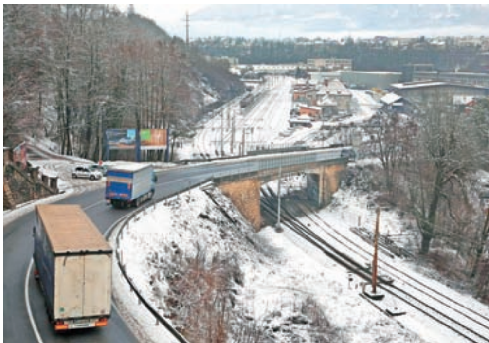
Med načrtovanimi investicijami je tudi most nad železnico v Kranju. / Foto: Gorazd Kavčič
