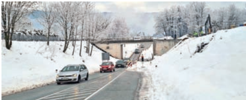
Ob straneh starega podvoza bodo uredili nove preboje pod železnico, namenjene kolesarjem in pešcem. Odsek ceste bo zato pri Lescah do sredine marca zaprt za promet.
