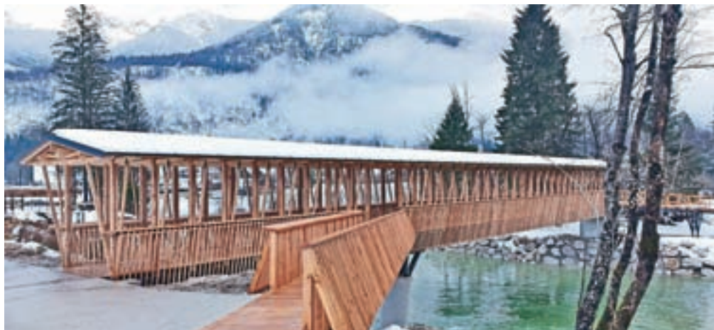
Novi kolesarski most na Rju v Kamnjah pri Bohinjski Bistrici
