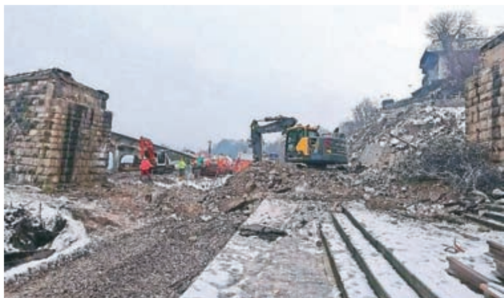
Stari most nad železniško postajo v Radovljici so v petek podrli. Dostop do pokopališča je urejen čez Linhartov trg, ki je v času do izgradnje novega mostu odprt za promet.
