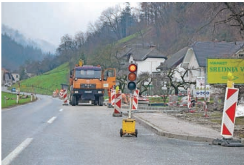
Gradnja meteorne kanalizacije in pločnika v Srednji vasi naj bi bila zaključena v začetku leta.
