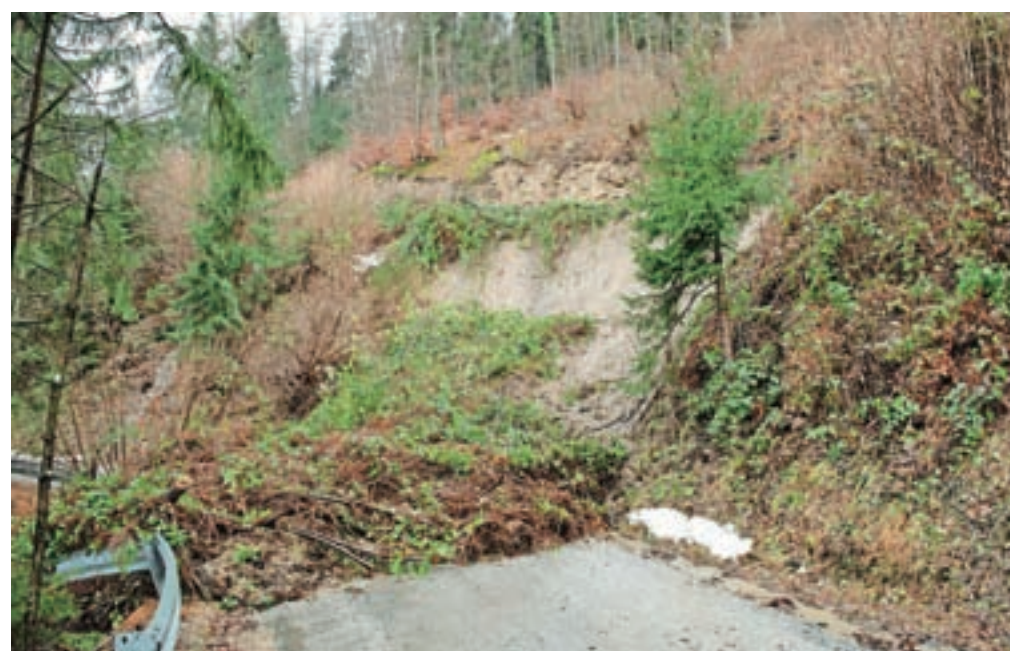
Plaz pri Jamniku so delavci Gorenjske gradbene družbe včeraj odstranili. / Foto: Primož Pičulin
