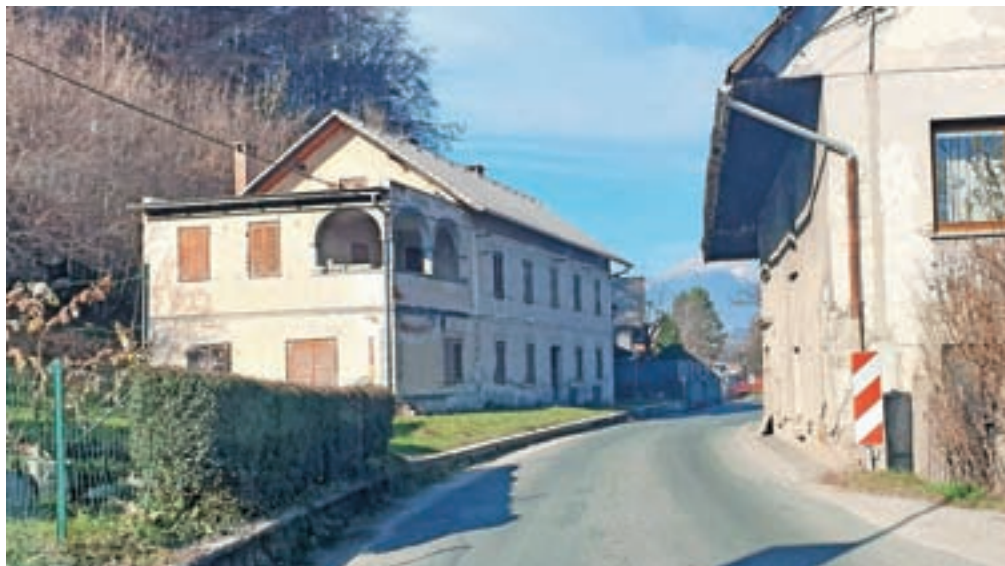
V sklopu projekta ureditve ceste skozi Podnart na direkciji za infrastrukturo vodijo aktivnosti za rekonstrukcijo ceste skupaj z ureditvijo pločnikov, odvodnjavanja, prometne opreme ter cestne razsvetljave.
