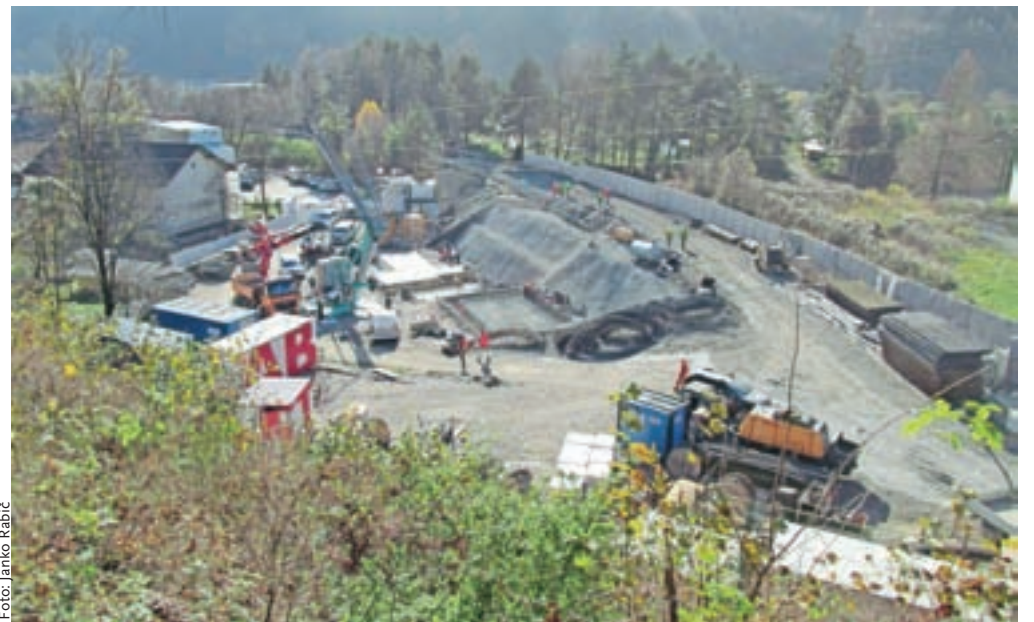
Sredi Hrušice je veliko gradbišče, poteka prenova železniškega predora Karavanke.
