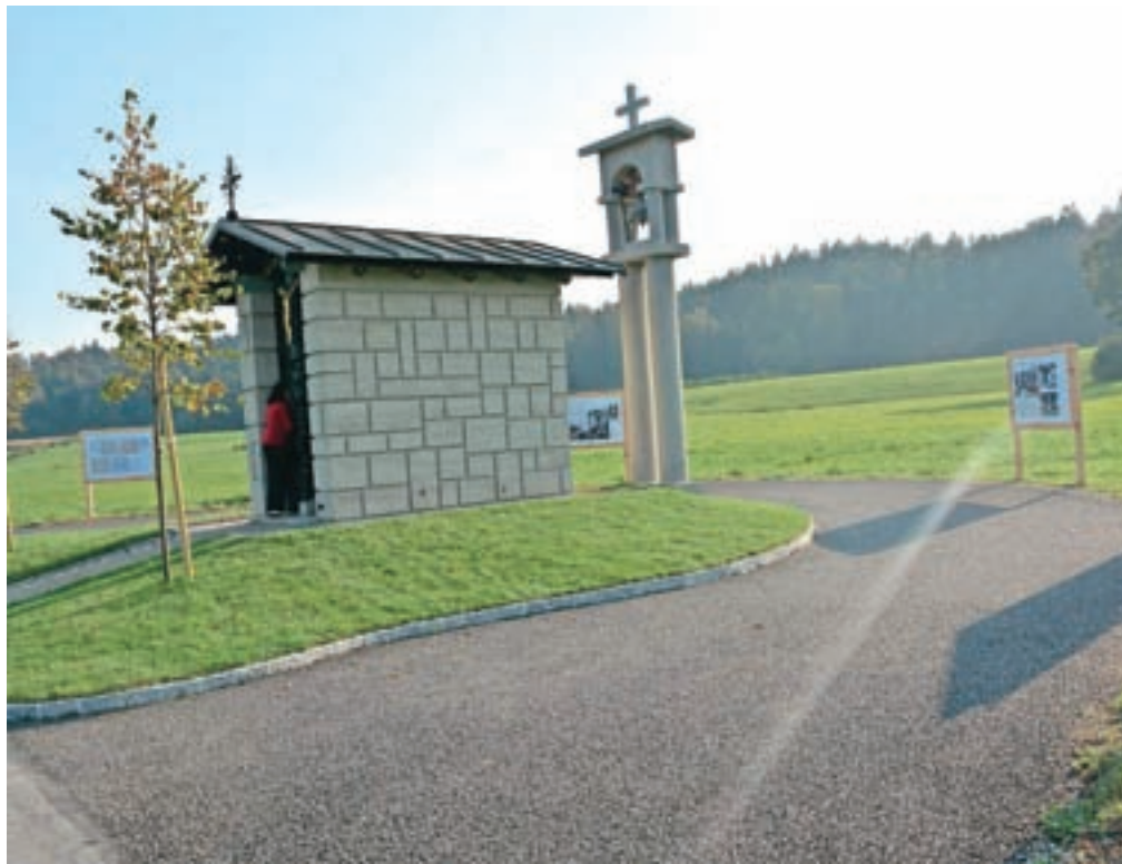
Načrt za kapelico je pod vodstvom arhitekta Jožeta Plečnika risal Janez Valentinčič, Plečnikov takratni asistent na ljubljanski tehniški fakulteti. Vodil je tudi njeno gradnjo. Po obnovi je zasijala v novi luči.
