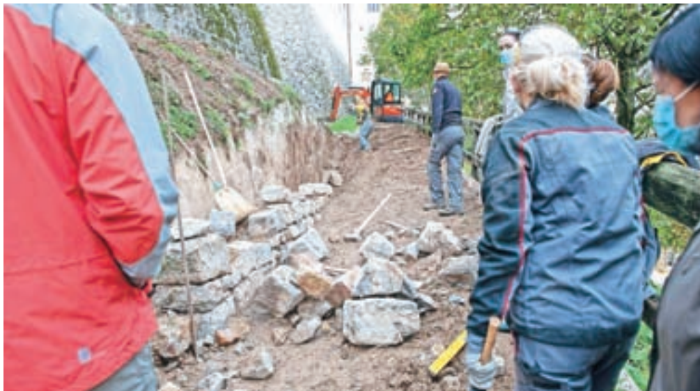
Delavnica suhozidne gradnje na Loškem gradu / Foto: Primož Pičulin
