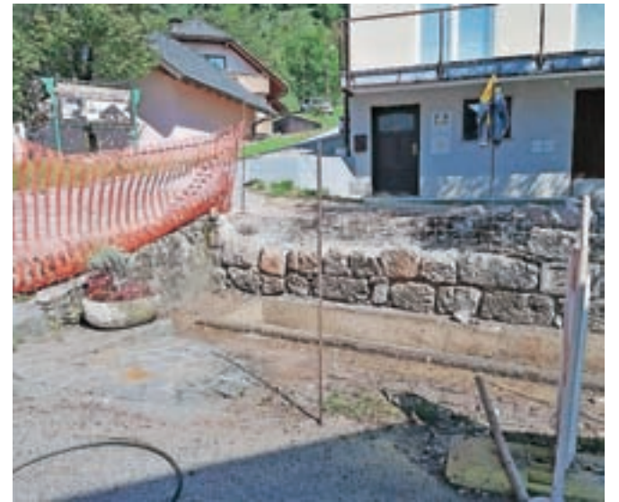
Vaško korito je bilo poškodovano, zato ga obnavljajo.
