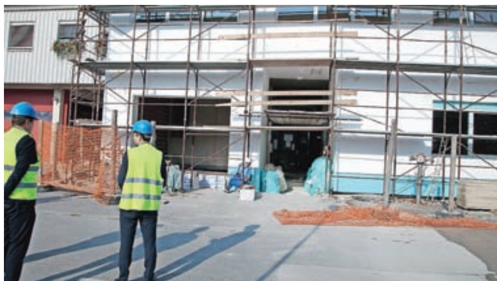
Štabna soba Občinskega štaba Civilne zaščite bo urejena v prizidku h gasilskemu domu.
