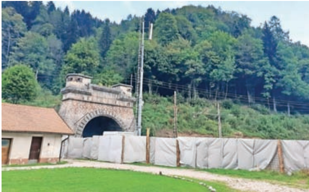
Prenova železniškega predora Karavanke se je začela, gradbišče je v celoti ograjeno, ne nazadnje so v neposredni bližini tudi otroški vrtec, otroško igrišče in balinišče.
