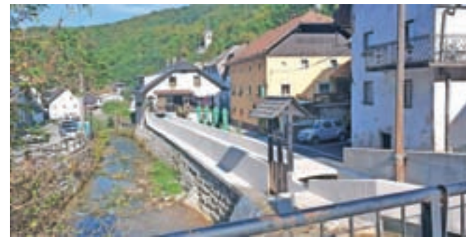
Obnovljene rake v Kropi; nekdanja lesena, kasneje pa kamnita korita so poganjala vodna kolesa, ta pa prek prenosov mehove in težka kladiva kroparskih kovačev.
