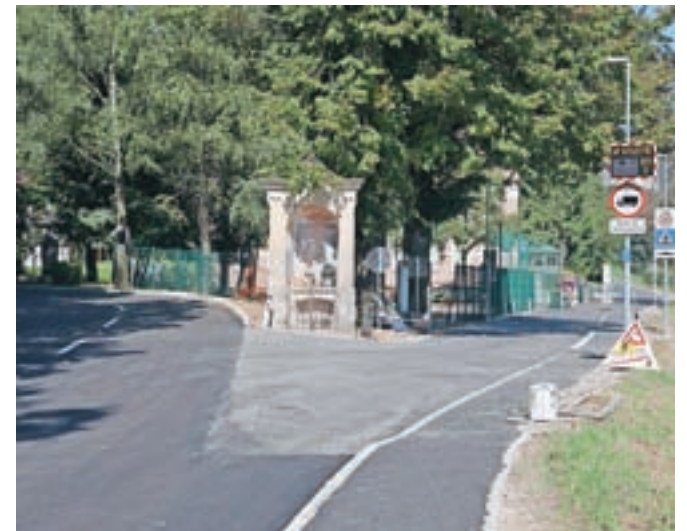
Zaključujejo največji letošnji projekt v občini, in sicer novogradnjo fekalne kanalizacije, obnovo komunalnih vodov in obnovo cest v Podbrezjah. /Foto: Gorazd Kavčič
