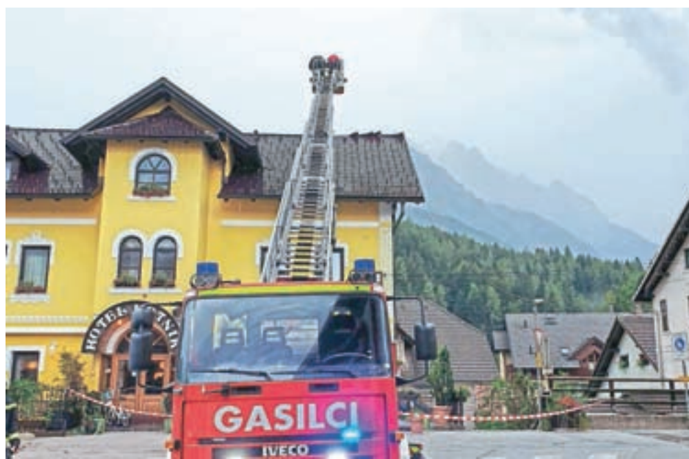
Pokrivanje strehe hotela Kotnik v Kranjski Gori / Foto: PGD Kranjska Gora
