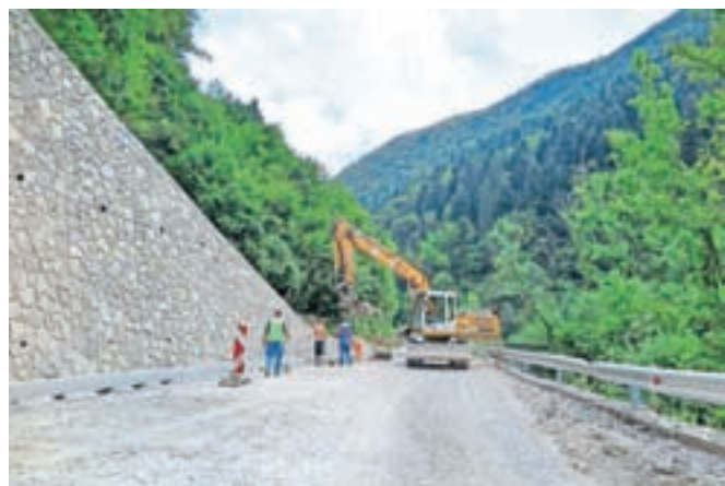
Najprej bodo dokončali cesto ob brežini nad Zalim Logom (na sliki), kmalu pa se bodo lotili še odseka pri davškem mostu.
