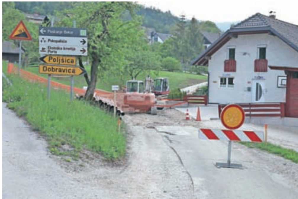
Občina Radovljica je jeseni začela obnavljati vodovod v naseljih Ovsišje, Dobravica in Poljšica pri Podnartu. V sklopu obnove bodo na novo uredili tudi odseke ceste v skupni dolžini 1800 metrov. / Foto: Gorazd Kavčič
