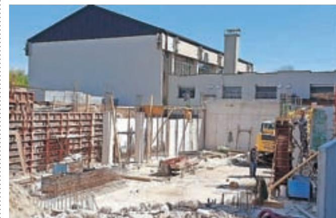
Gradnja prizidka je v polnem teku. / Foto: Občina Domžale
