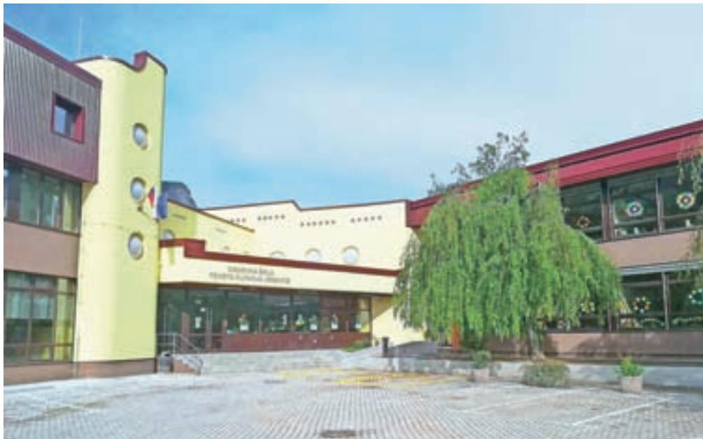
Osnovna šola Toneta Čufarja Jesenice je zdaj energetska sanirana, ima tudi novo fasado in streho.
