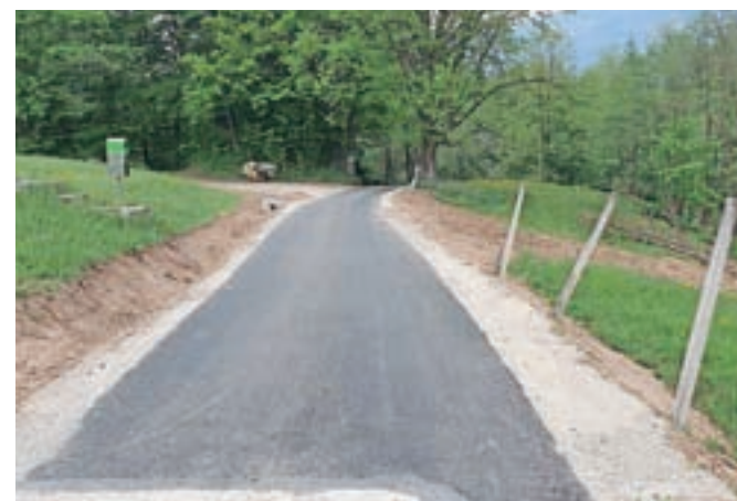
Ta mesec so končali sanacijo usada na cesti Ljubno – Praproše.
