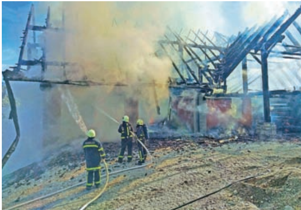
Ostrešje in stanovanjski del, zgrajen iz hlodovine, sta pogorela v celoti. / Foto: Jože Kamenšek
