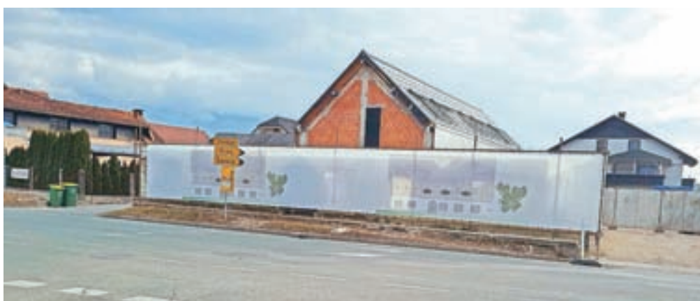
Ruševine Blagneče hiše so zdaj zakrite in zavarovane.
