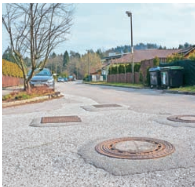
Cestišče v Zbiljskem gaju ima samo prvo plast asfalta in komunalni jaški štrlijo iz nivoja.
