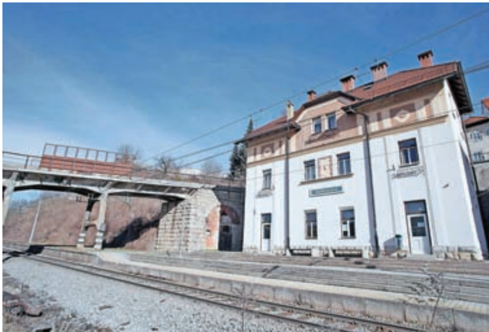
V sklopu rekonstrukcije proge je načrtovana tudi gradnja novega mostu čez progno pri železniški postaji v Radovljici. / Foto: Gorazd Kavčič
