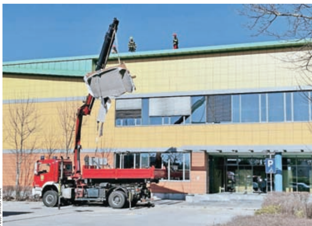
Odstranjevanje poškodovane pločevine s strehe na Gimnaziji Franceta Prešerna v Kranju
