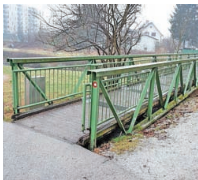
Most pri Šumberku bodo začeli obnavljati sredi februarja.
