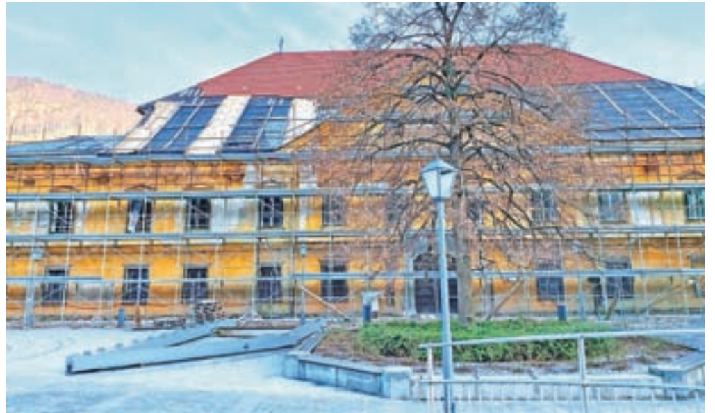
Stavba iz 16. stoletja je kulturni spomenik državnega pomena in je bila nazadnje obnovljena med letoma 1972 in 1976. V potresu leta 1998 je bila močno poškodovana. Občina je postopoma pridobivala dokumentacijo za obnovo, celovita obnova se je začela predlani.
