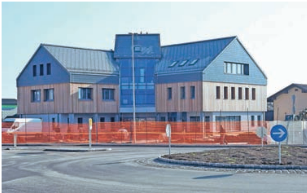
Gradnja zdravstvenega doma v Cerkljah aktivno poteka, do konca februarja bodo predvidoma zaključena že vsa obrtniška dela v notranjosti. / Foto: Gorazd Kavčič
