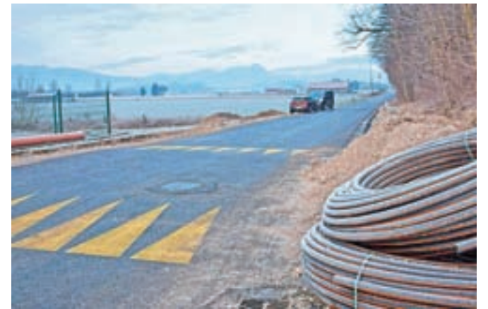
Na Jeprci je že dolgo načrtovana obrtna cona (v ozadju). To območje bo sedaj končno komunalno opremljeno.
