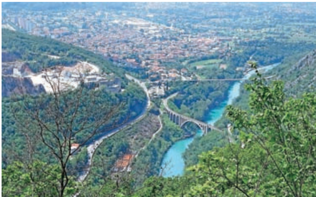
Pri sestopu na izhodišče se lepo pokaže Nova Gorica in arhitekturno čudo, železniški Solkanski most. / Foto: Jelena Justin
