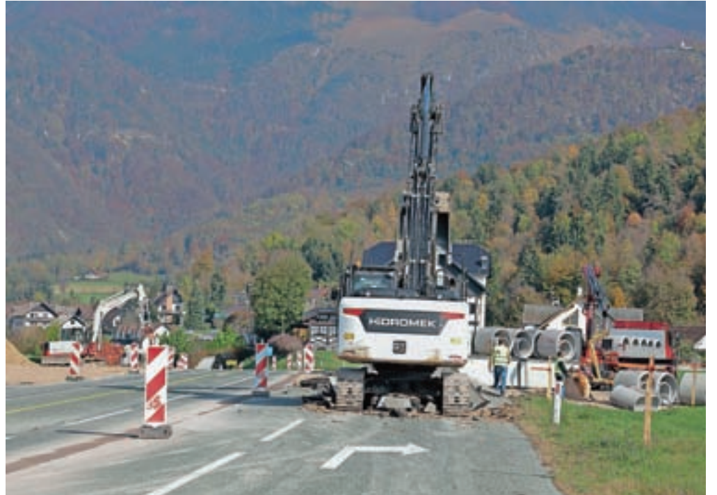
V Tupaličah so začeli graditi krožno krožišče. / Foto: Tina Dokl
