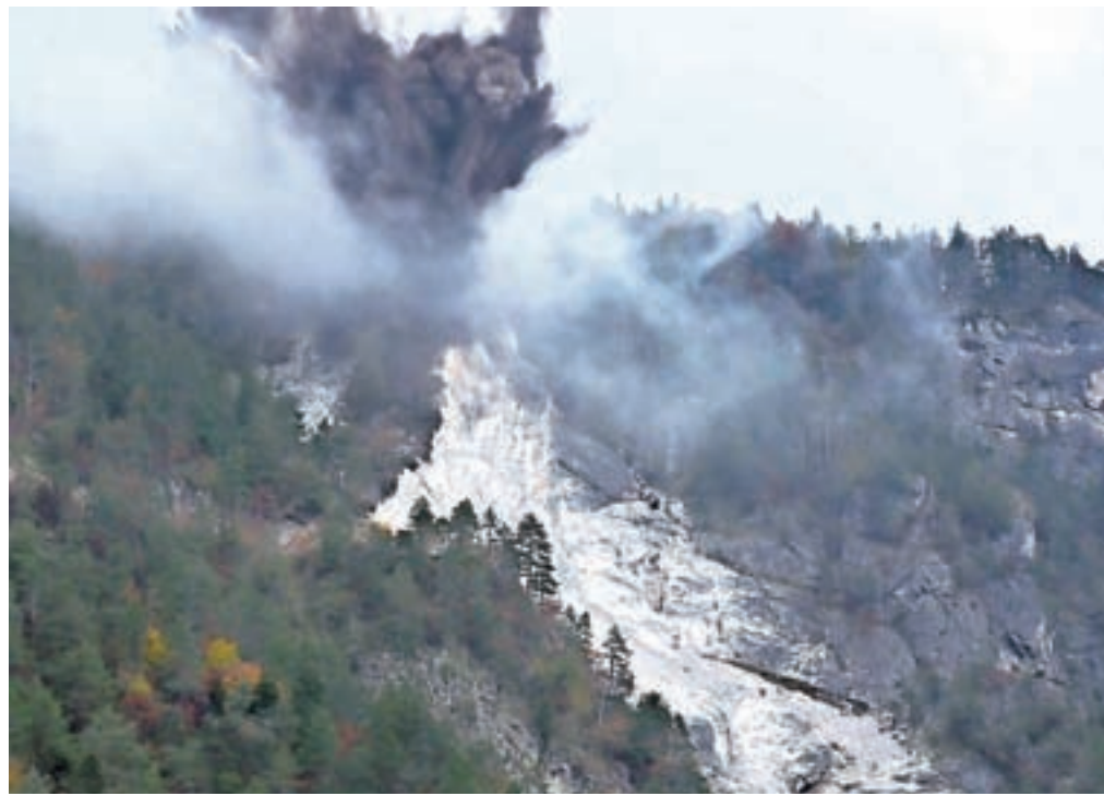
Prejšnji teden so izvedli drugi delni odstrel kamnitega bloka na dveh mestih. Po prvih ocenah so odstrelili od trideset do petintrideset tisoč kubičnih metrov kamnine.
