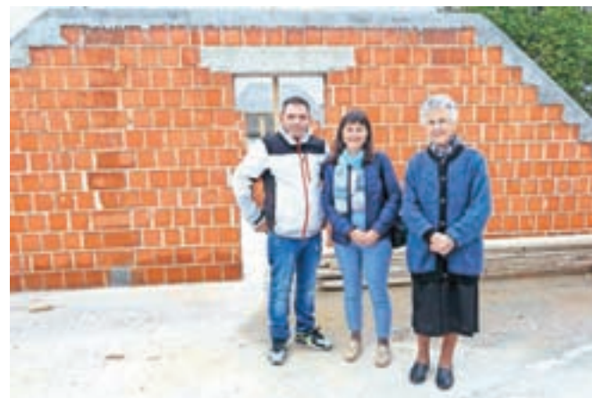
Mama in hči Ivanka in Suzana Šenk ter odgovorni gradbenik Osman Bytyqi pred hišo v gradnji
