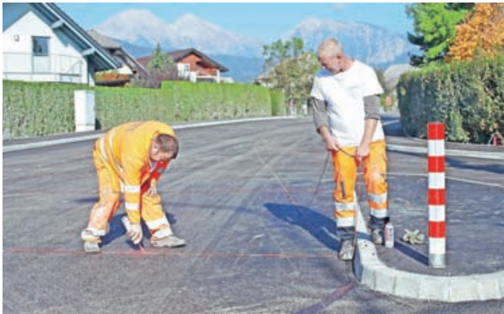
V okviru projekta Gorki 2 poteka gradnja komunalnega omrežja v aglomeraciji Britof - Predoslje, minuli konec tedna pa so asfaltirali križišče v Britofu. / Foto: Gorazd Kavčič
