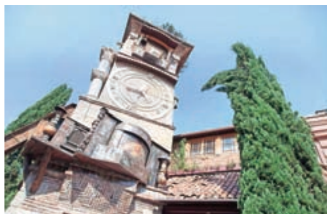
Poševni stolp lutkovnega gledališča
