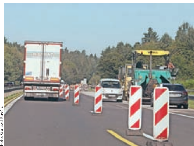
Promet po gorenjski avtocesti poteka po že ustaljenem režimu, zaprt pa sta uvoz in izvoz Kranj zahod.
