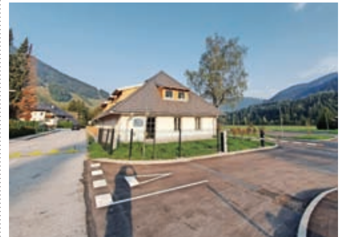
Železničarski dom bo po prenovi namenjen letovanju aktivnih železničarjev in železniških upokojujencev v Skupini Slovenske železnice.
