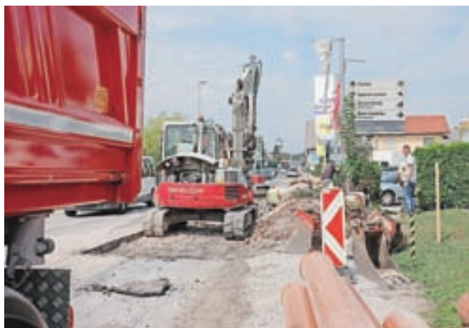
Gradnja novega odseka kolesarske steze in peš poti se je začela prejšnji teden. / Foto: Tina Dokl
