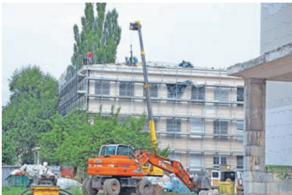
Konec junija se je začela prenova vrtca in Podružnične osnovne šole Simona Jenka Center v Kranju. / Foto: Tina Dokl
