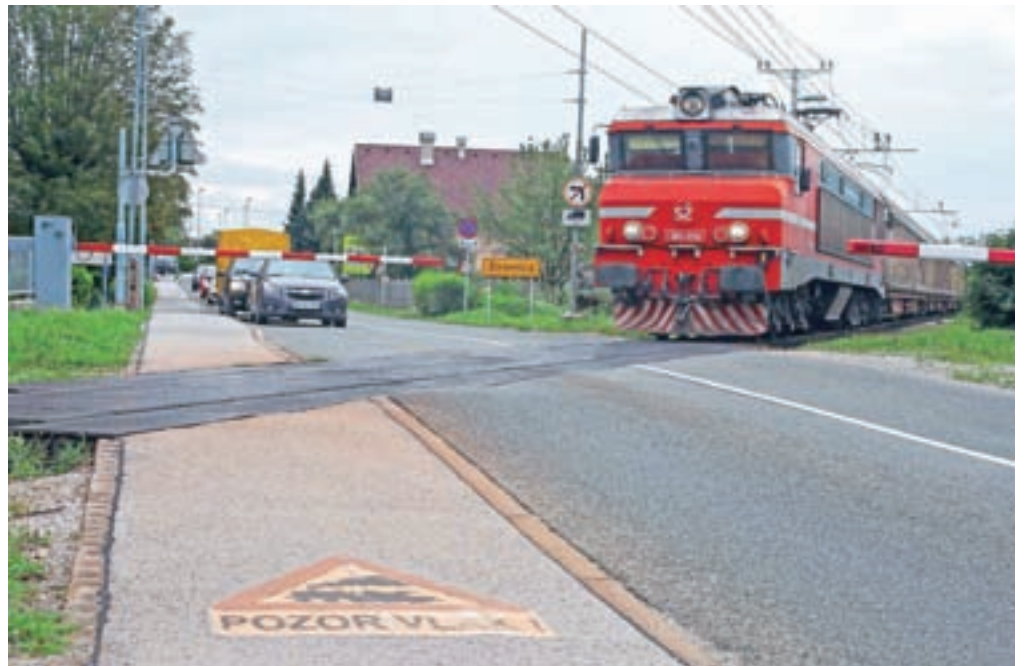
Občina Žirovnica je direktorju za infrastrukturo že predlagala, naj zagotovi zunajnivojsko križanje regionalne ceste in železniške proge v Žirovnici. / Foto: Gorazd Kavčič
