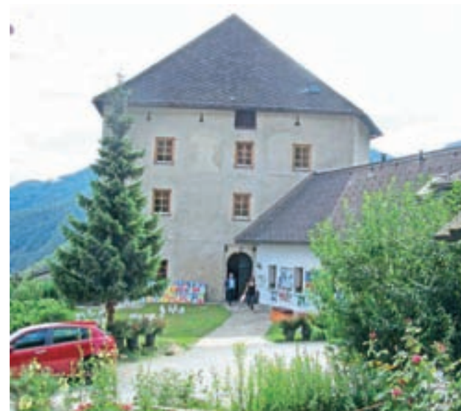
Več kot osemsto let star grad oziroma »komenda« na Rebrci je sedaj Mladinski center, ki je še potreben obnove. Ustanovitelj centra kapelski župnik Polde Zunder računa tudi na pomoč države in dežele.
