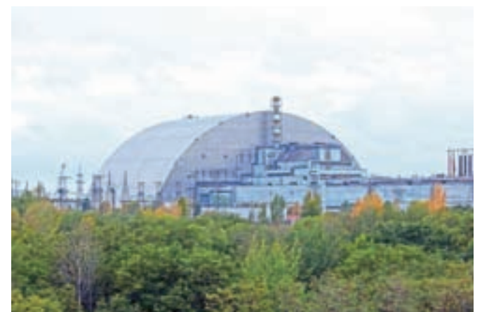
Novi varnostni sarkofag, ki pokriva v eksploziji razrušeni četrti reaktor černobilske jedrske elektrarne, posnet oktobra 2017 / Foto: Wikipedija
