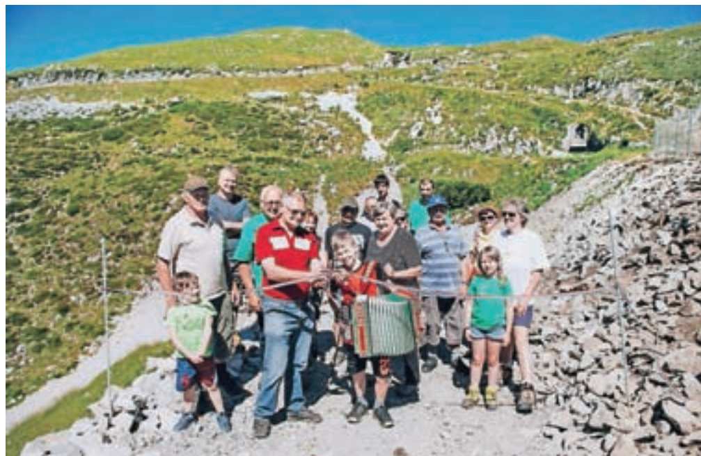
Udeleženci srečanja rejcev drobnice so slavnostno prerezali trak in uradno odprli novozgrajeno cesto, ki vodi od Litostrojske kočice do pastirske staje na Soriški planini. / Foto: Primož Pičulin
