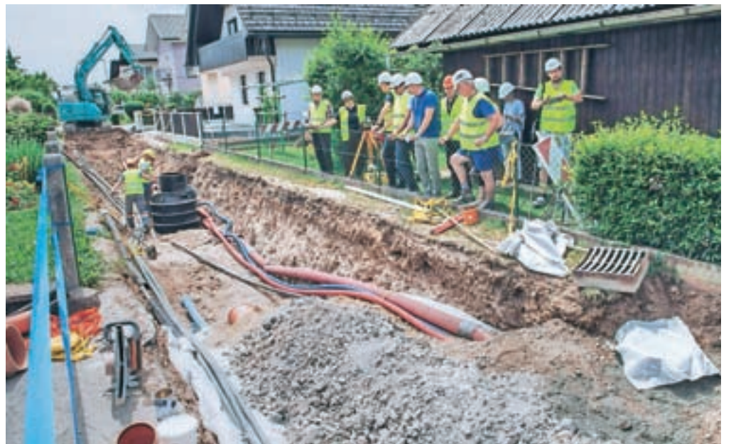
Gradbena dela v Britofu potekajo po načrtih. V začetku tedna so si gradbišče skupaj ogledali tudi predstavniki kranjske občine in izvajalcev. / Foto: Primož Pičulin
