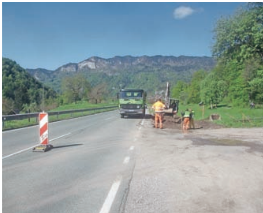
Začela se je gradnja kolesarske steze Bled–Bohinj.
