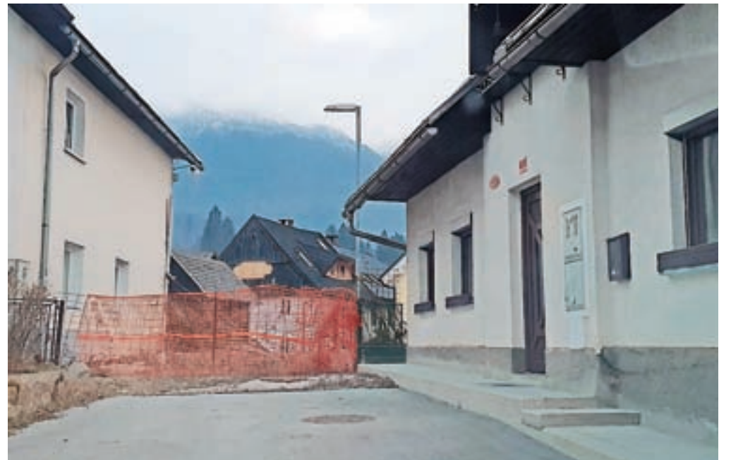
Grajska ulica v Bohinjski Bistrici bo do sodnega epiloga od hišne številke 4 naprej zaprta, hišo na naslovu Grajska ulica 6 pa so zaradi poškodb že porušili. / Foto: Andraž Sodja
