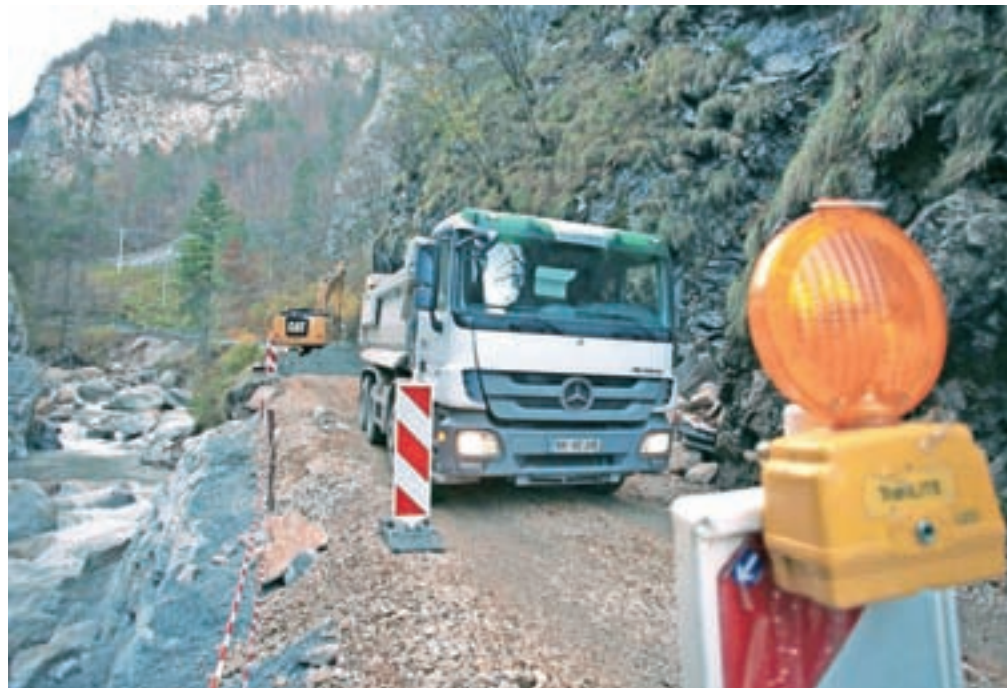
Delavci podjetja VGP se vse dni trudijo, da čim prej zagotovijo prevoznost ceste v Dovžanovi soteski. / Foto: Gorazd Kavčič
