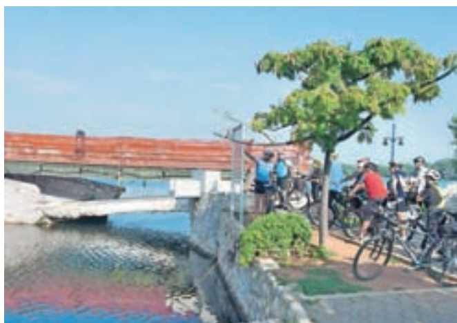
V poplavah porušeni most v Ninu / Foto: Jože Cimperman
