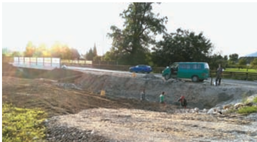
Gradnja zaščitnih ograj in urejanje okolice severne razbremenilne ceste.
