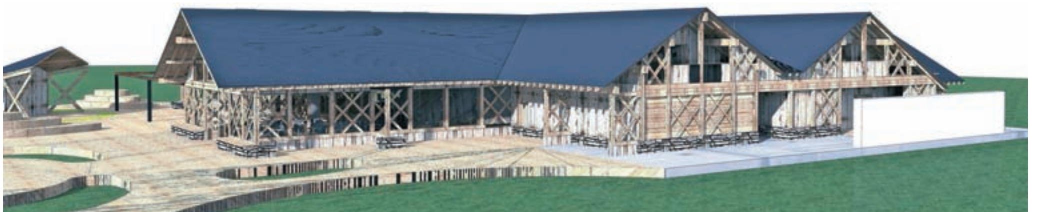
Novi objekt z restavracijo bodo zgradili na mestu sedanje trgovine. Glavni gradbeni material bo les, objekt bo zelo odprt, pritičen in zelo razgiban, z veliko teraso in prireditvenim prostorom. Ogrevan bo s toplotno črpalko, ki bo izkoriščala vodo iz bajerja, imel bo sončno elektrarno ...
