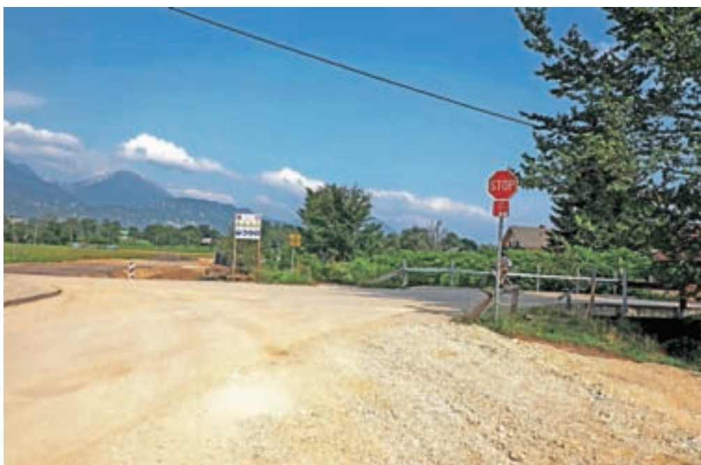
Most na Buču bodo porušili in zgradili novega. Obvoz bo urejen po gradbišču, za pešce in kolesarje bodo zgradili leseno brv. / Foto: Tina Dokl
