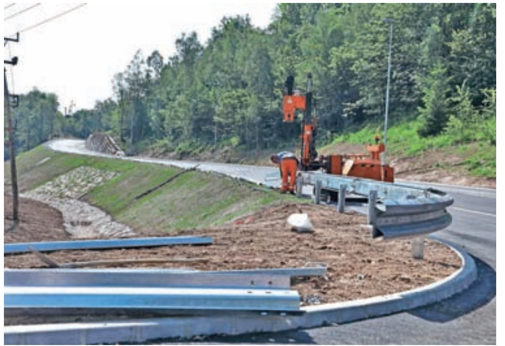
Dela pri gradnji obvoznice mimo Lipc se zaključujejo. / Foto: Gorazd Kavčič
