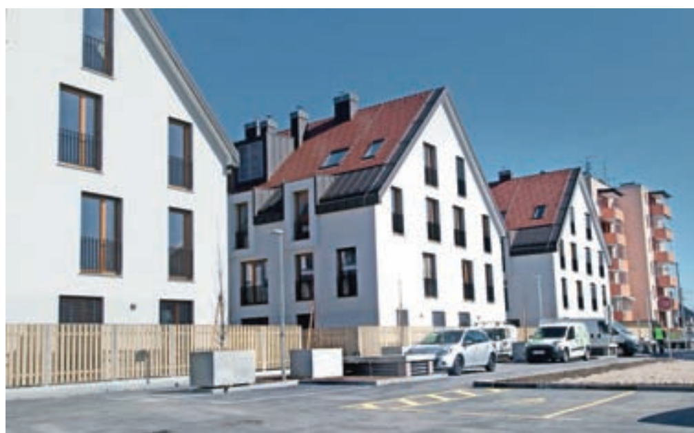
Trije stanovanjski objekti v centru Mengša že čakajo nove stanovalce.
