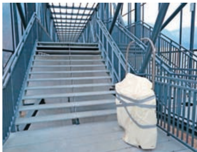
Dvižna ploščad za invalide je pokrita in ni v uporabi, zdaj bodo zgradili klančino.
